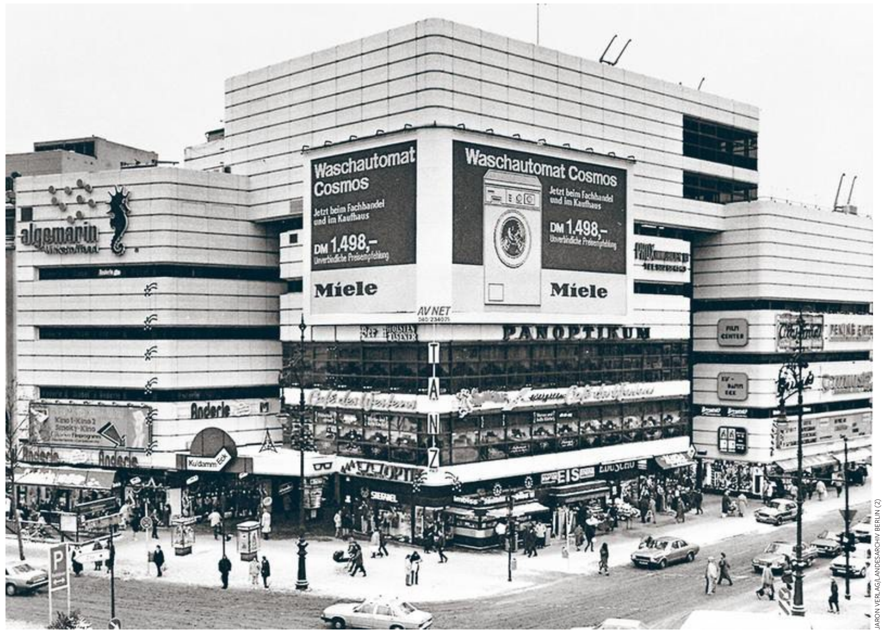
Das Ku'damm-Eck war für viele ein Synonym für die West-Berliner Bausünden der 70er-Jahre. 1996 wurde es geschlossen, asbestsaniert und später abgerissen
