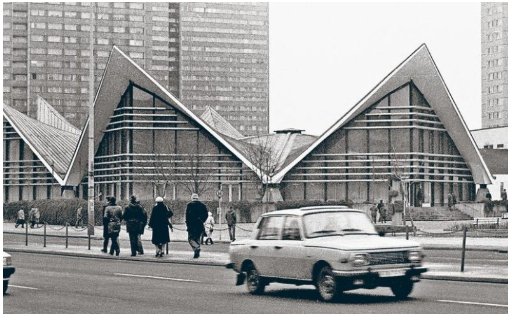
Im „Ahornblatt“ gab es eine Selbstbedienungsgaststätte. Es wurde im Jahr 2000 abgerissen
